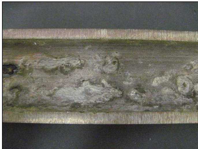
Fig. 66 : Tronçon 16, après décapage
