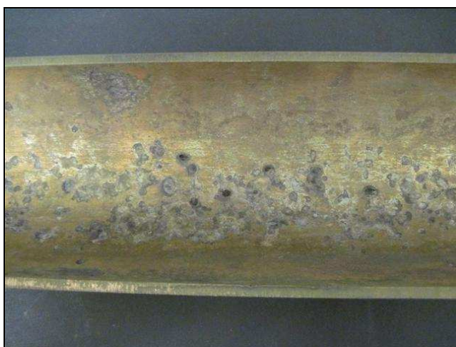
Fig. 72 : Tronçon 18, après décapage
