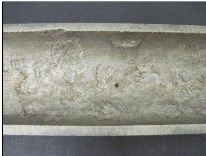
Fig. 48 : Tronçon 10, après décapage
