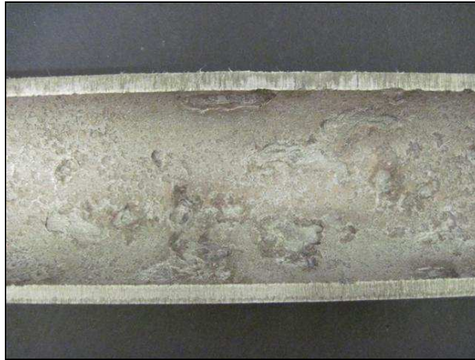
Fig. 33 : Tronçon 5, après décapage
