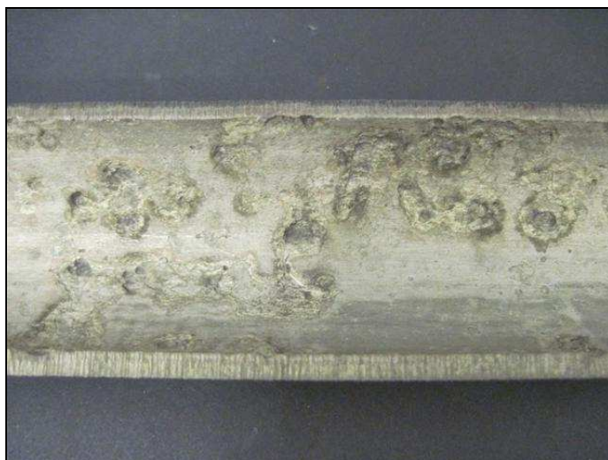
Fig. 54 : Tronçon 12, après décapage
