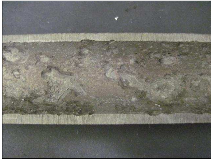
Fig. 51 : Tronçon 11, après décapage
