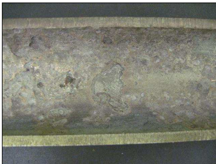
Fig. 45 : Tronçon 9, après décapage
