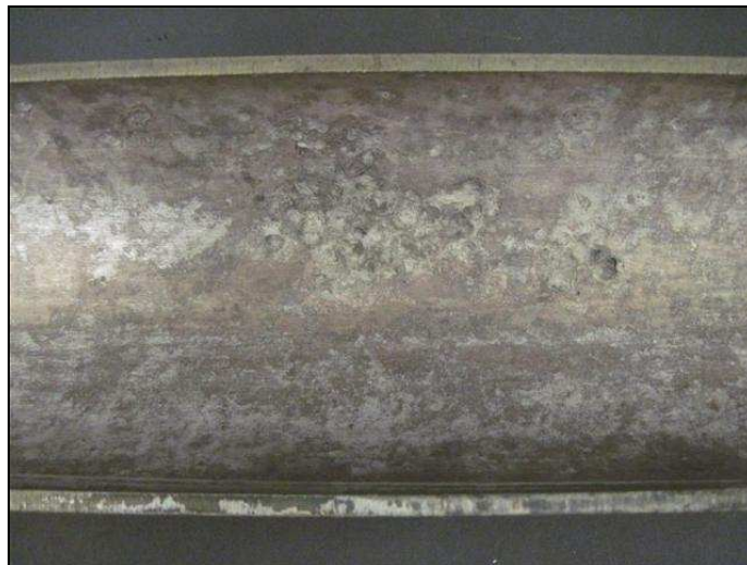
Fig. 39 : Tronçon 7, après décapage
