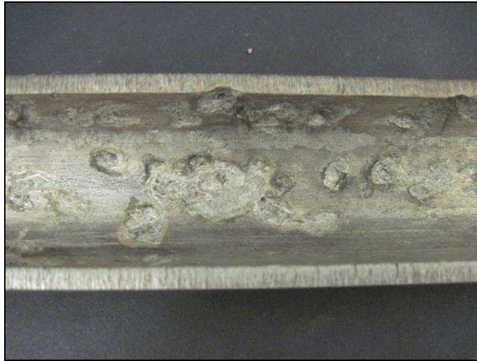
Fig. 42 : Tronçon 8, après décapage
