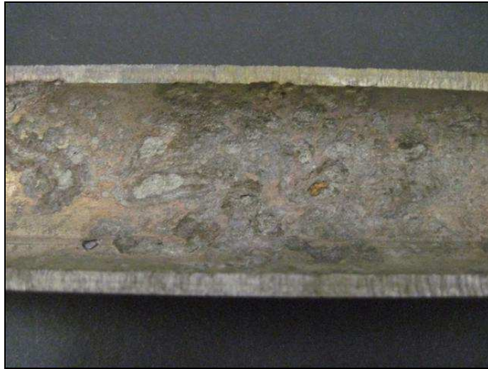
Fig. 24 : Tronçon 2, après décapage
