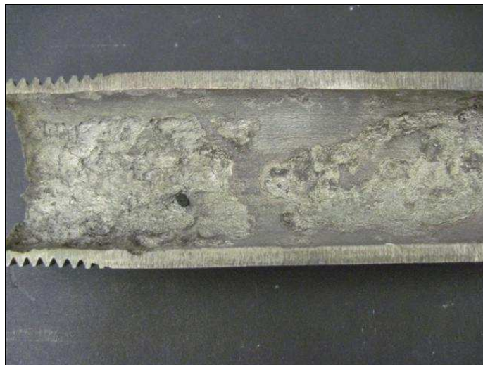
Fig. 57 : Tronçon 13, après décapage
