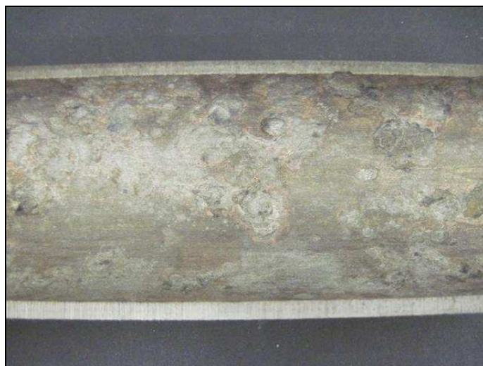
Fig. 36 : Tronçon 6, après décapage
